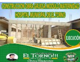
21. CONSTRUCCION OBRA GRUESA MODULO MATERNIDAD HOSPITAL
