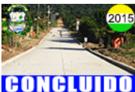
15. CONSTRUCCION DE PAVIMENTO H-23 EL TORNO DISTRITO N°3
