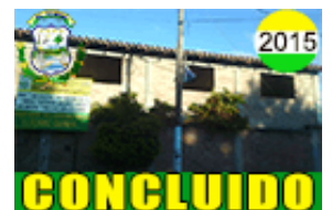
20. CONSTRUCCION 2DA FASE DOS AULAS UNIDAD EDUCATIVA NACIONES UNIDAS
