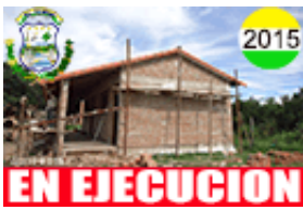
6. CONSTRUCCION DOS AULAS UNIDAD EDUCATIVA TIQUIPAYA DISTRITO N° 4
