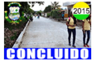
14. CONSTRUCCION DE PAVIMENTO CON HORMIGON H-23 JOROCHITO EL TORNO DISTRITO N°4
