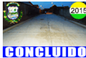
13. CONSTRUCCION DE PAVIMENTO SIN PROVISION DE HORMIGON DISTRITO N°10 ZONA MERCADO MUNICIPAL DE EL TORNO Y DISTRITO N°8 CUARTA FASE
