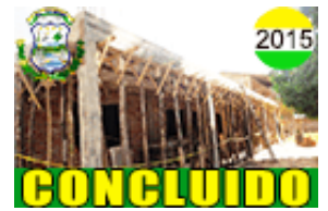
10. CONSTRUCCIÓN DOS AULAS UNIDAD EDUCATIVA ZACHARY MACY – OBRA GRUESA
