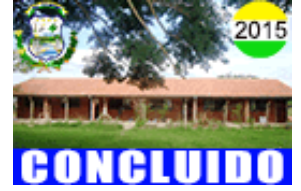
5. CONSTRUCCION SEGUNDA FASE KINDER SAN LUIS D-5
