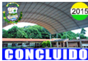
7. CONSTRUCCION TINGLADO METALICO U.E 29 DE JUNIO JOROCHITO D-4
