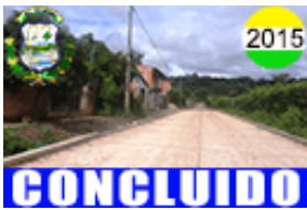
11. CONSTRUCCION DE PAVIMENTO EL TORNO BARRIO VILLA NUEVA CALLE SUCRE DISTRITO N°10
