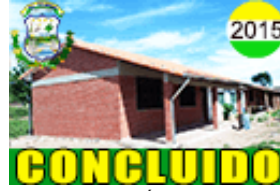
4. CONSTRUCCIÓN DE UN AULA UNIDAD EDUCATIVA ALBERTO RIBERA TAPIA LA ANGOSTURA D-5
