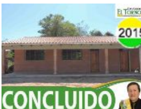
22. CONSTRUCCION AULAS Y DIRECCION UNIDAD
